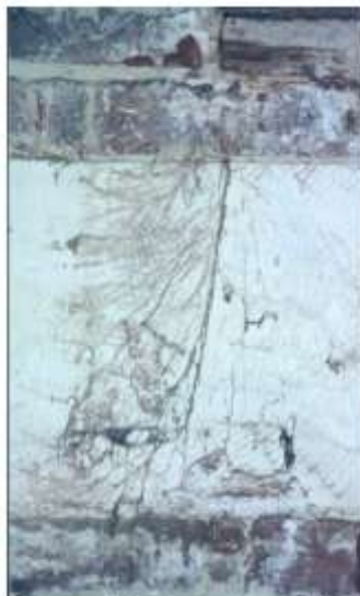
Fig.5 – Rhizomorphe (notez l'orientation : développement vers le bas)
