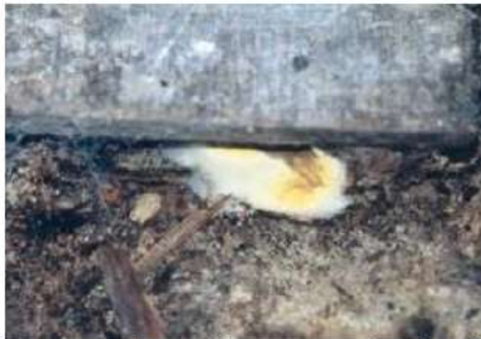
Fig. 3 – Forme fructifiée sous un plancher humide
